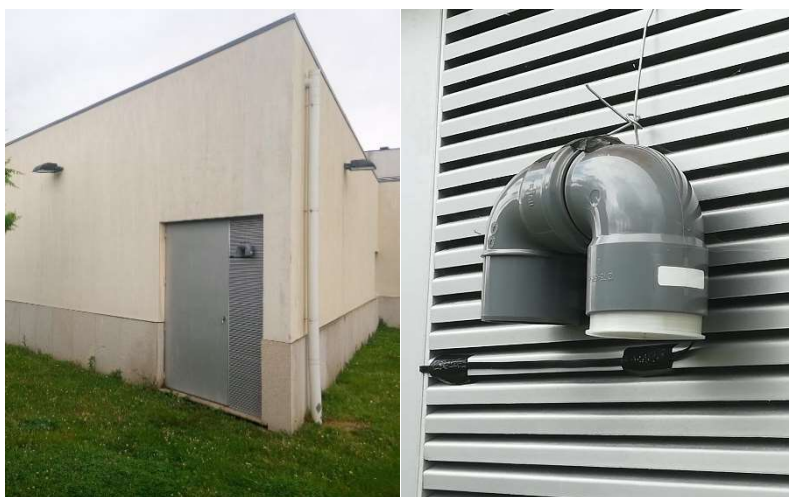
Figura 1 – Instalação do aparelho de medição no exterior da ESCE
